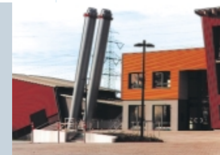
Blockheizkraftwerk Dorfanger Boberg
